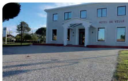
Rénovation parvis – Mairie
