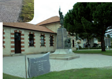
Rénovation parvis – Monument aux morts
